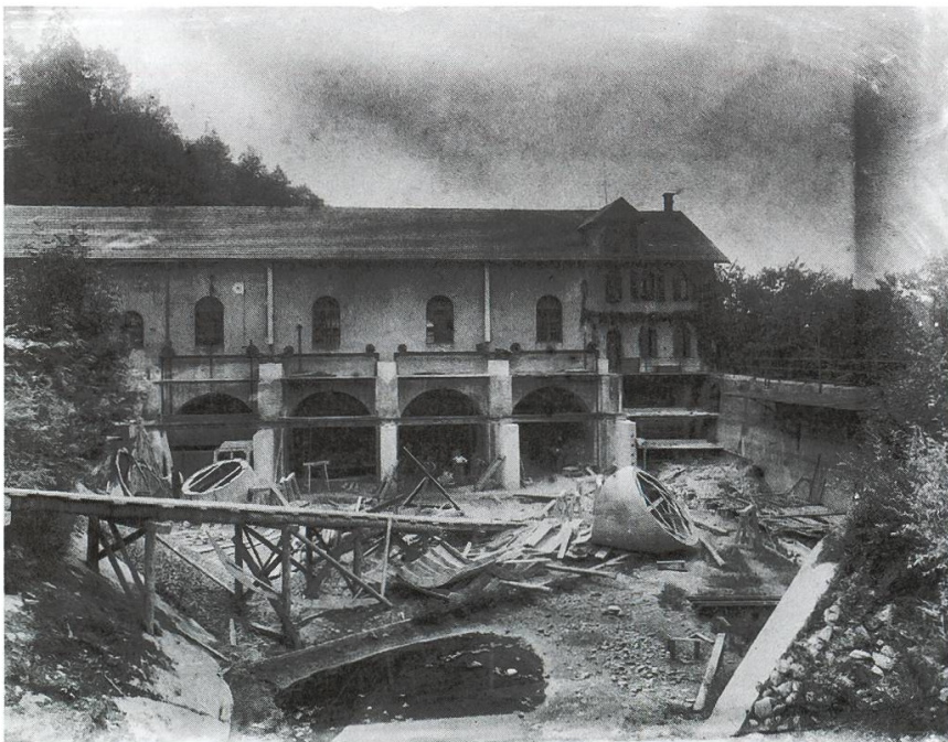
11 Kraftwerk Aue, Umbauarbeiten im Sommer 1918 (Foto: Historisches Museum Baden, Fotohaus Zipser, StAB Q.12.1.518).
