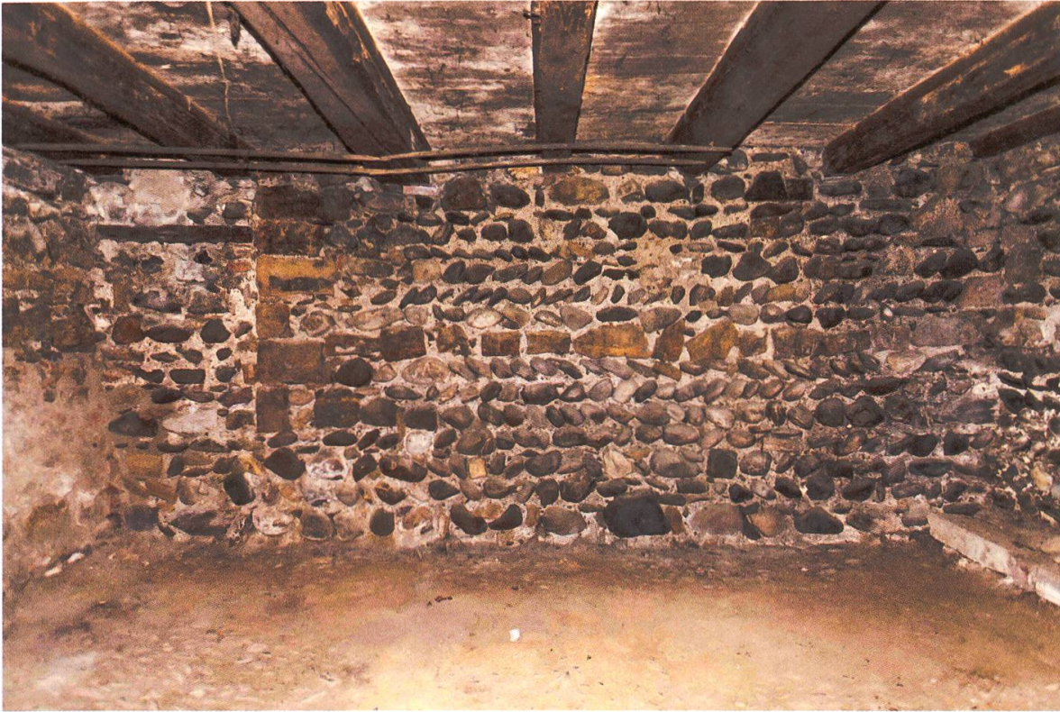
8 Klingnau-Goldgässli. Kernbauzeitliches Mauerwerk aus dem 13. Jh., teilweise im Ährenverband aufgemauert (Kgn.017.1).
