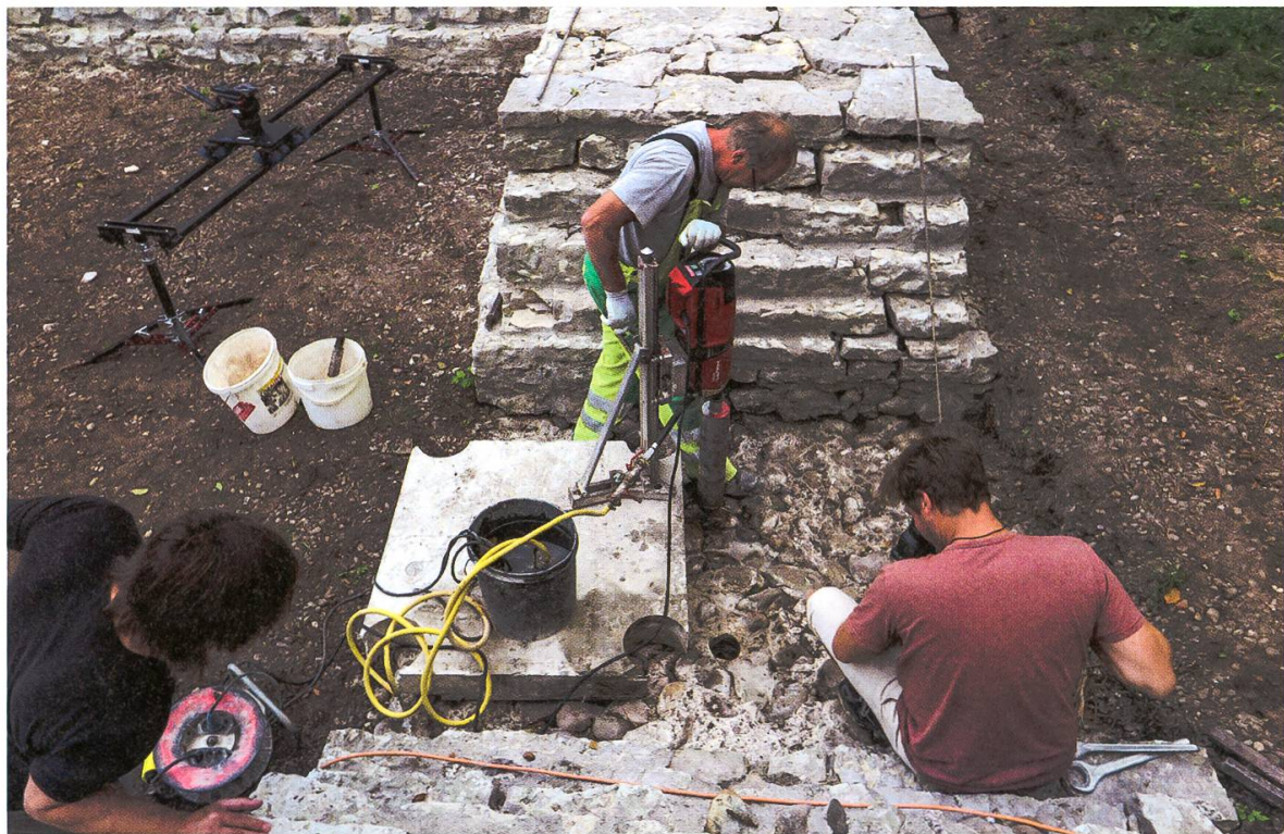
2 Rheinfelden-Pferrichgraben. Blick auf den Eingangsbereich des spätrömischen Wachturms. Mörtelproben werden mittels Kernbohrungen für die ^{14}\text{C} - beziehungsweise Radiokarbonanalysen entnommen. © Vindonissa-Professur, Universität Basel.
