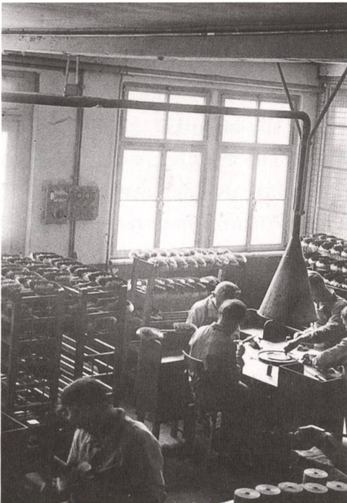
5 Blick in die Pecherei. Diese Art der Produktion wurde vor allem für Besen eingesetzt. Ein Bündel Pferdehaar wurde mit einem Draht zusammengebunden, in flüssiges Pech getaucht und ins vorgebohrte Loch gesteckt. Dort klebte dann der Besatz fest (Bild: Bürstenfabrik Walther AG, Bestand Industriemuseum).
