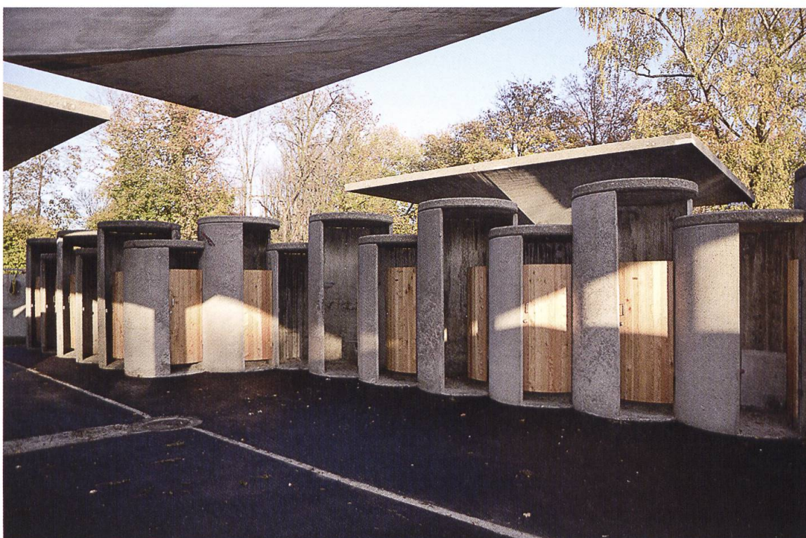
4 Wohlen, Freibad Bünz matt. Das 1965/66 von Dolf Schnebli erbaute Freibad Bünz matt in Wohlen, das unter anderem durch Pilzdächer und zylinderförmige Umkleidekabinen charakterisiert ist, steht seit 2017 unter kantonaalem Schutz (Foto: © Kantonale Denkmalpflege Aargau, Isabel Haupt, 2018).
