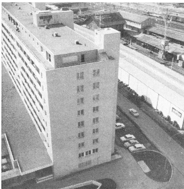
Stützpunkt «Hochhäuser Winkelriedstrasse» Ansicht des Gebäudeblocks C Blick auf Ost- und Südfassade Standort des Beobachters auf der Dach- terrace des Hochhauses B Rechte obere Bildecke: Gleisfeld SBB, mögliche Panzerdurchbruch- achse
