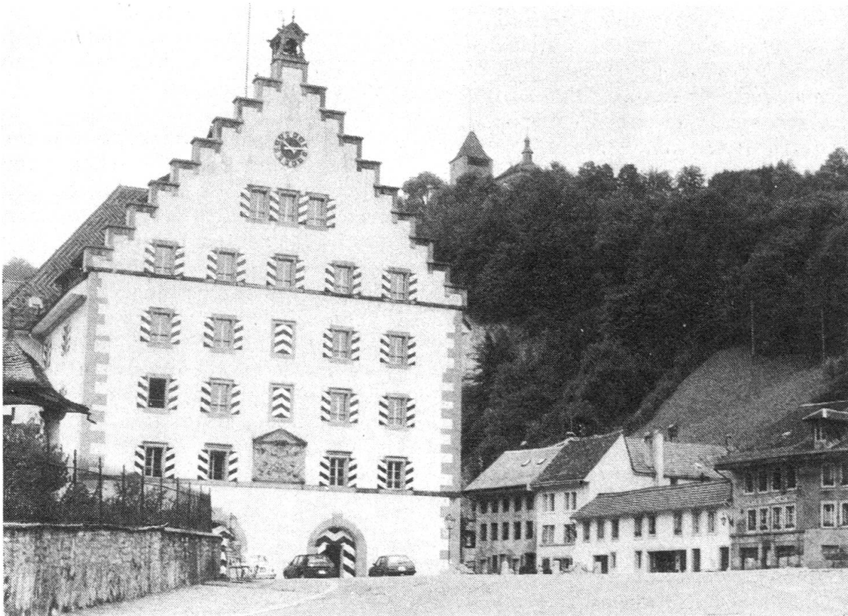
Diese Kaserne in der schön herausgeputzten Altstadt von Fribourg (es ist diejenige der Versorgungs-Truppen RS/UOS) zeigt deutlich, was aus einer ehemals verlotterten, hygienisch gar nicht über allen Zweifeln stehenden Baute gemacht werden konnte. Mit Hilfe des Heimatschutzes wurde sie renoviert und präsentiert sich sowohl innen als auch aussen mit dem gut erhaltenen Umgelände heute als markanten Mittelpunkt der Altstadt. Einziger Wermutstropfen bei dieser Bundesunterkunft: Die Ruhe wird von den Altstadtbewohnern so über alles geschätzt, dass die Armee-Motorfahrzeuge ausserhalb der Altstadt parkiert werden müssen und der morgendliche Spaziergang der Rekruten zu den Transportmitteln zum gewohnten «Dorf-Bild» gehört.
