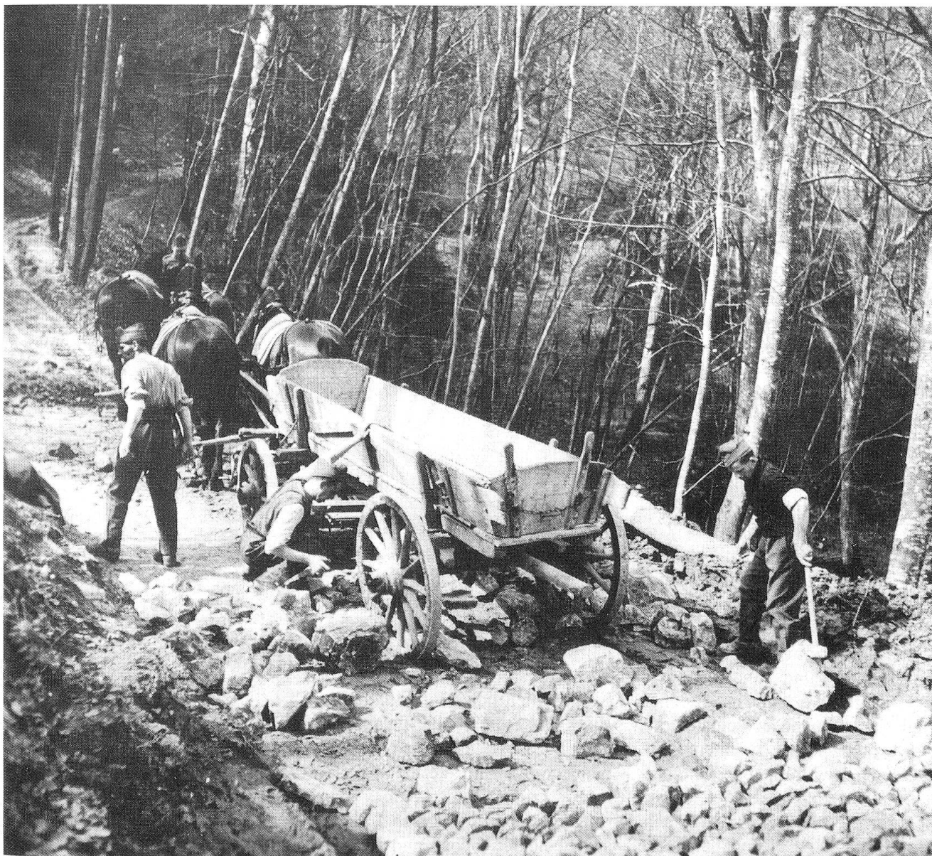
Zur Erschliessung der oft in unwegsamem Gelände liegenden Bauplätze wurden Dutzende von Strassen und Wegen neu erstellt oder bestehende Holzwege mit solidem Steinkoffer versehen. Unser Bild wurde dem Buch «Die Limmatstellung im Zweiten Weltkrieg» entnommen und stammt von Carl Mugglin, Luzern, III/43.
