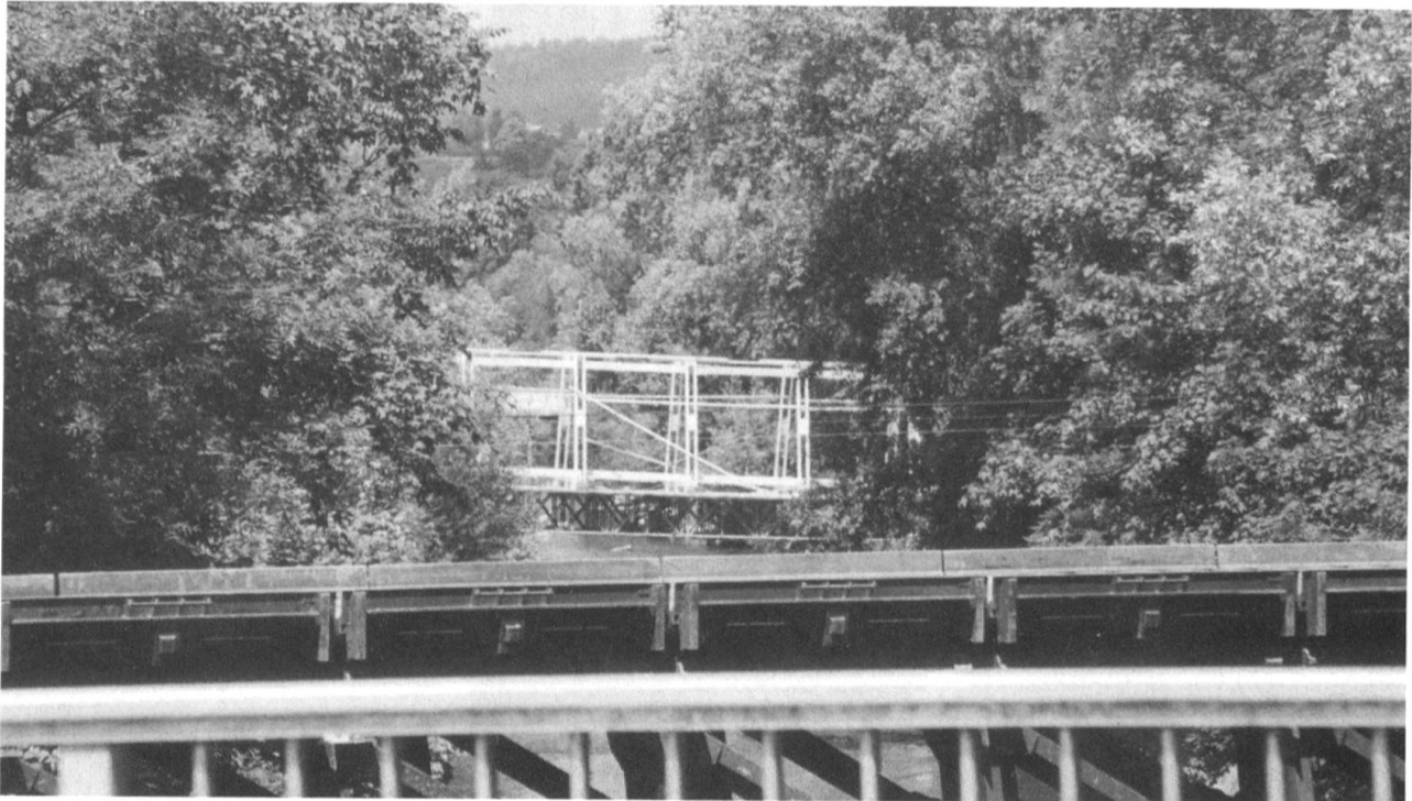
Ein eindrückliches Bild boten auch die von den Genietruppen erstellten Brücken über die Murg. Insgesamt wurden mit fünf Brücken, vom Fussgängersteg bis hin zur 50-Tonnen-Brücke die Geh- und Fahrverbindungen auf der Allmend sichergestellt.
