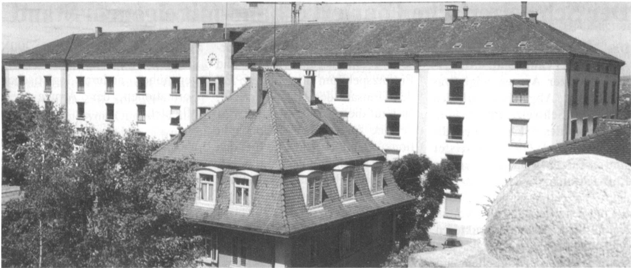
Der Bau dieser alten Kaserne in Frauenfeld und die Inbetriebnahme des Artillerie-Waffenplatzes geht ins Jahr 1863 zurück.
