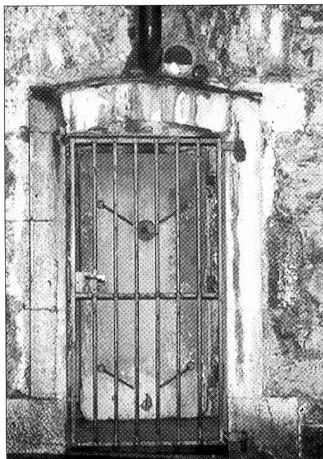
Grille et porte blindée de l'entrée de l'abri. Photos: Fernand Gardy
