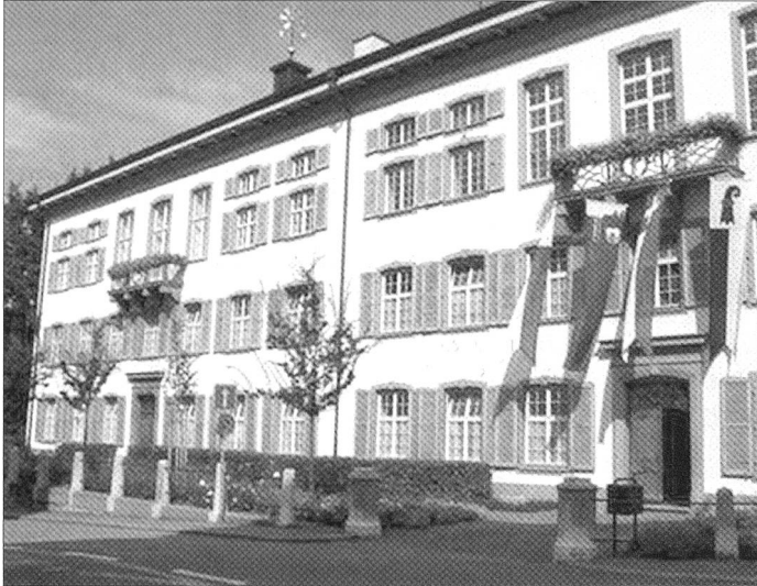
Stolz und ehrwürdig präsentiert sich heute noch das Regierungsgebäude.
