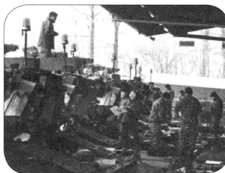
Fassung und WEMA immer am gleichen Standort
