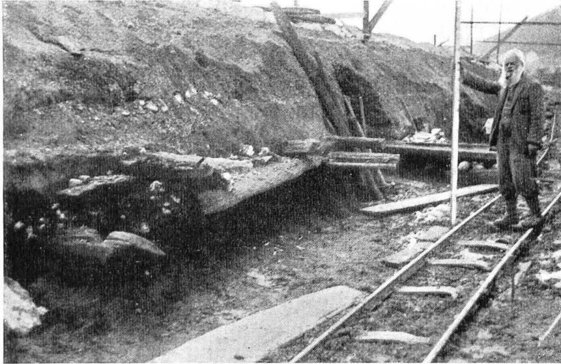
Abb. 12. Holderbank. Holzbalken frühromischer Bauten. Im Hintergrund Torschwelle; daneben der Entdecker J. L. Karpf.
