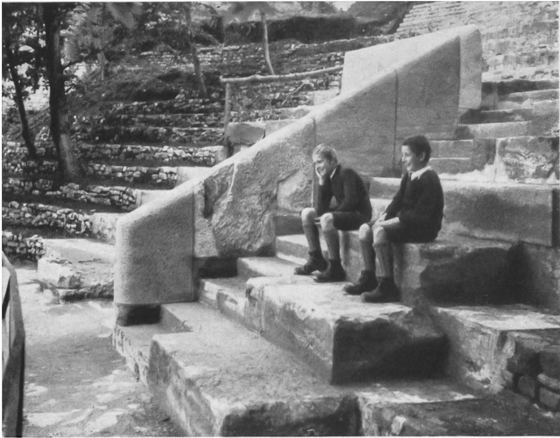
Abb. 26. Augst, Theater. Wiederhergestellte Sitzstufen.
