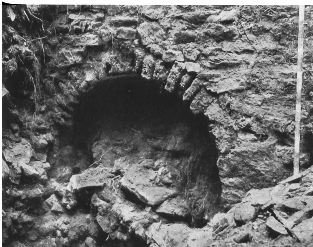
Abb. 42. Tegna. Mittlerer Bogen der Kellerwand während der Ausgrabung.
