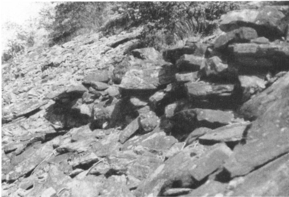
Abb. 5. Balla Drume. Stützmauer der Strassenrampe, die auf den Balla Drume führt.
