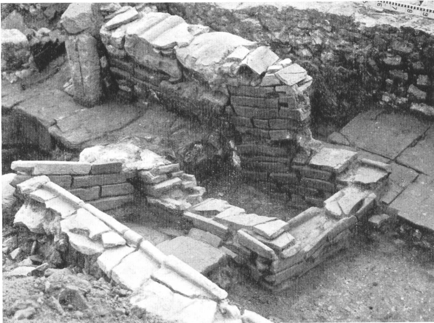
Abb. 36. Feuerkanal der Rauchkammer nach Entfernung des oberen Bodens.
