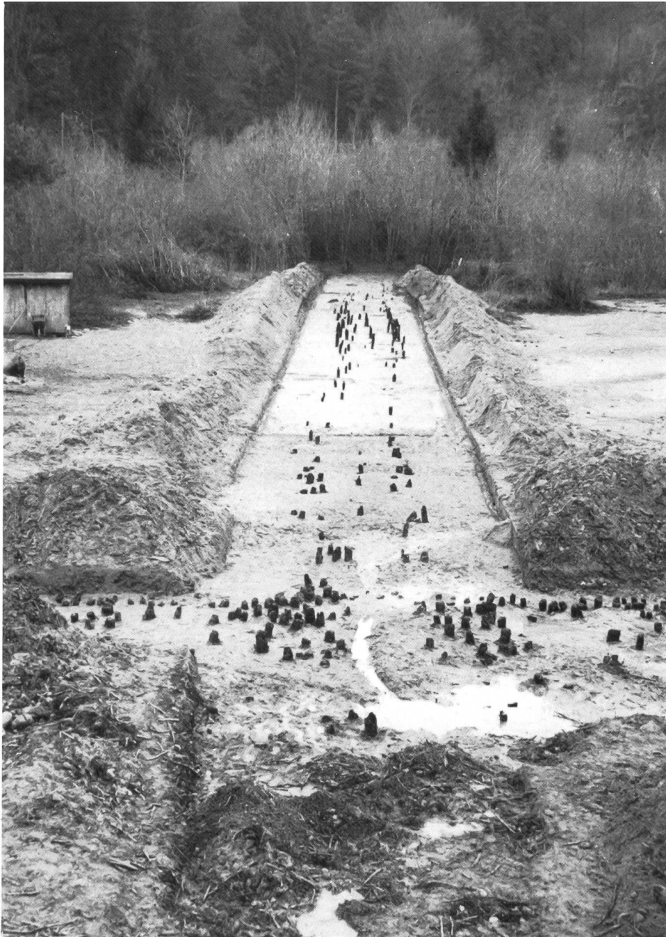
Abb. 23. Locras-Lüscherz. Vue générale du pont n° 1 et de son arrivée dans la station. (Photo A. Rais)
