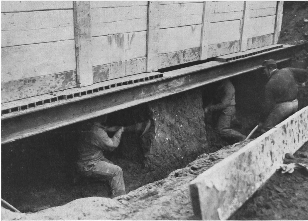
Abb. 54. Die Großgrabanlage wird mittels U-förmiger, schmaler Eisenschienen in Bergbaumanier unterfangen und anschließend auf drei Doppel-T-Eisen von je 500 kg Eigengewicht gelegt.
