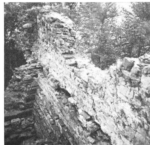
Abb.66. Westmauer mit Fensterlücke. Photos R. Laur-Belart
