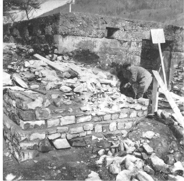
Abb. 47. Beginn der Konservierungsarbeiten: Vormauern.
