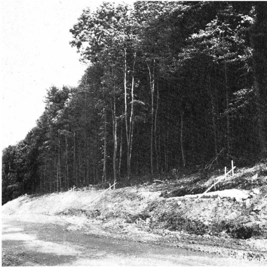
Abb. 37. Kaiseraugst, Hardhof. Römische Wasserleitung. Situation.
