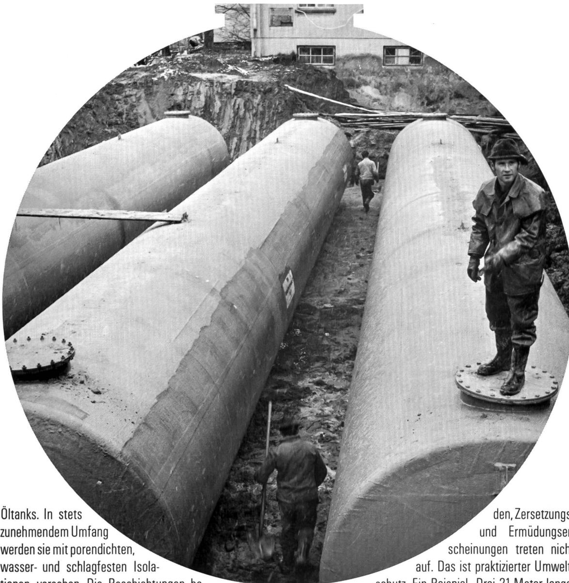
Öltanks. In stets zunehmendem Umfang werden sie mit porendichten, wasser- und schlagfesten Isolationen versehen. Die Beschichtungen bestehen aus Kunstharzen, in vielen Fällen verstärkt durch Glasgewebe. Sie verbinden sich so fest mit der Tankwand, dass man fast von einem zweiten Tank sprechen könnte. Ob aussen oder innen: Epoxidharz-Beschichtungen zeichnen sich aus durch Unempfindlichkeit gegenüber Chemikalien, Mikroorganismen und Nagetieren. Alterungsschä-
