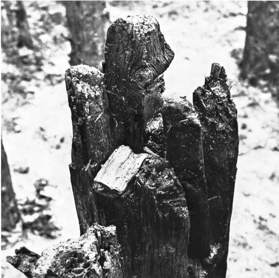
Abb. 18a: Detail des oberen Pfahlendes von Pfahl Nr. 456 mit Locheinschnitten, in denen sich z.T. noch Überreste des Oberbaues fanden.
