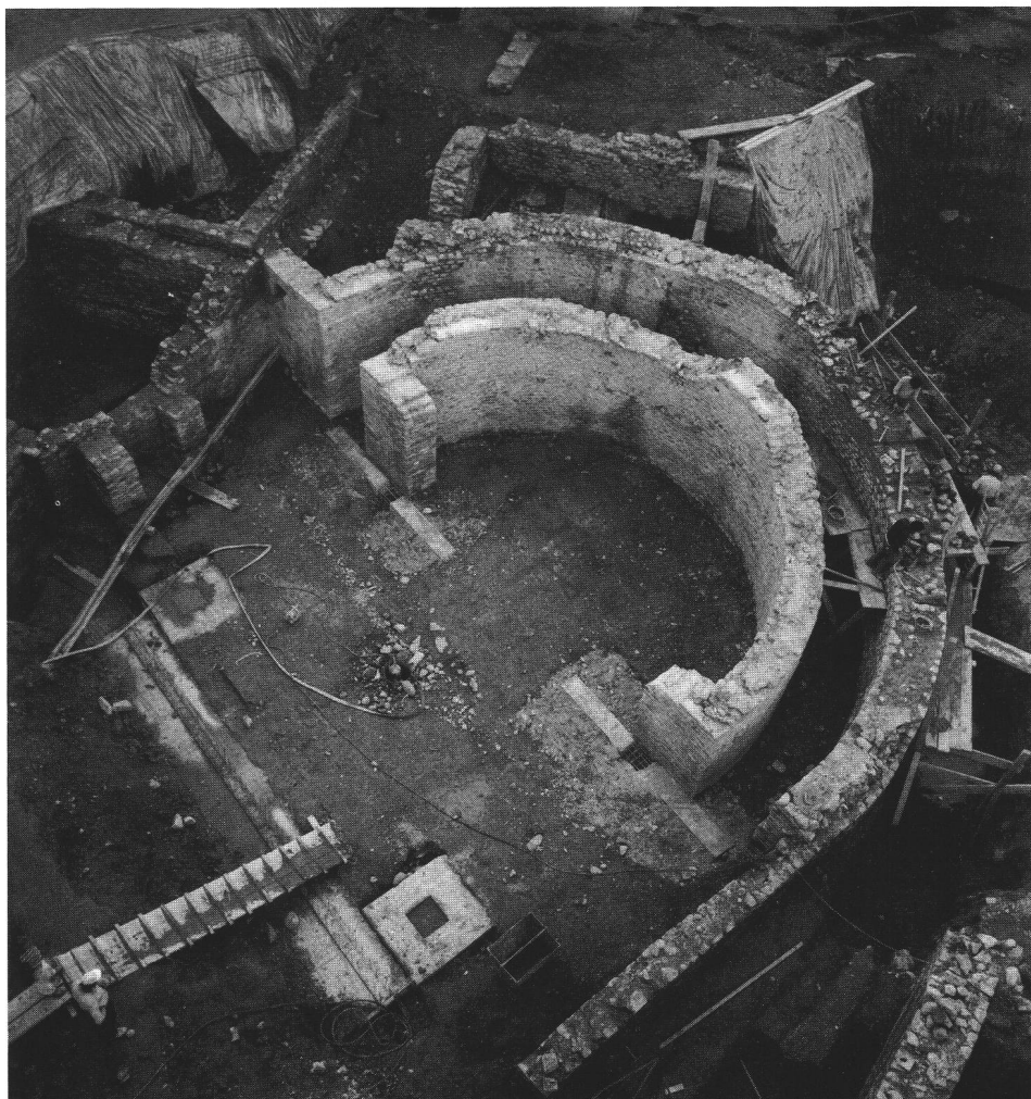
fig. 2 Le bâtiment F, pendant les travaux de restauration. Photo F. Francillon. Das Gebäude F während der Restaurierung. La costruzione F durante il ristauo.
