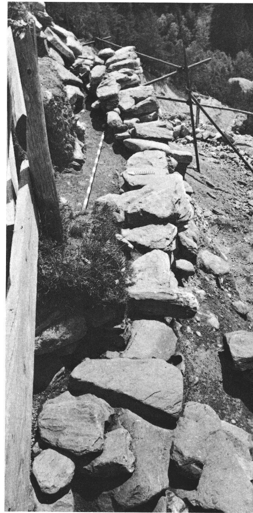
Abb. 9 Mauer 1 in der Süderweiterung der Felder 1 und 2 (nach 2. Abstich). Foto ADG. Mur 1 dans les secteurs 1 et 2. Muro 1 nei campi 1 e 2.
