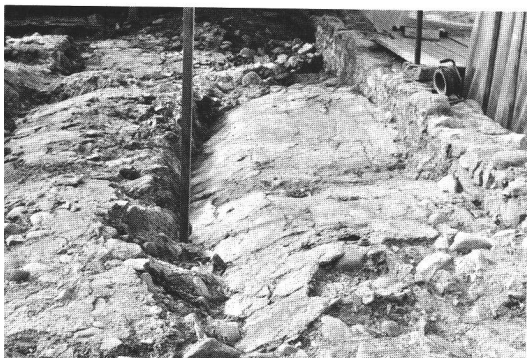
Abb. 4 Freigelegte Verputzfläche. Foto ADG. Surface d'enduit dégagé. Superficie incamiciata messa a giorno.
