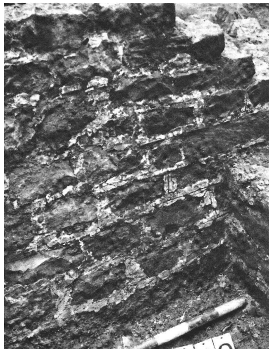
Abb. 6 Mauerwerk des älteren Steinbaus mit Fugenstrich. Maçonnerie de l'ancienne construction en pierre avec joints marqués à la truelle. Muro della prima costruzione di pietra.
