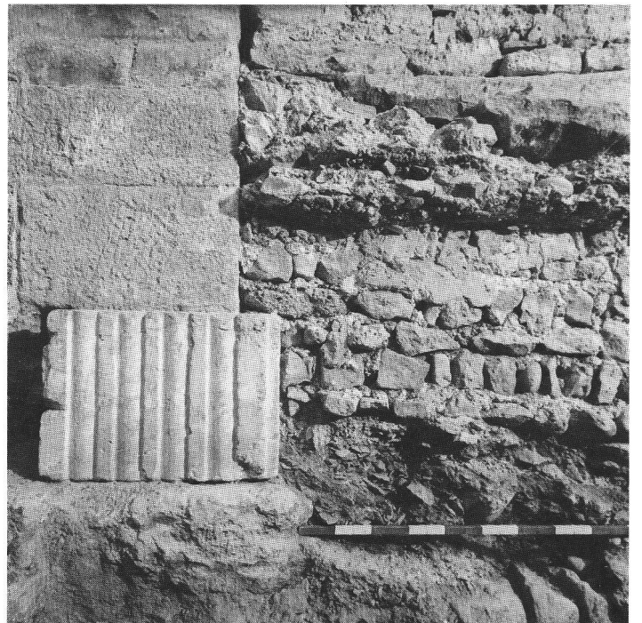
Abb. 4 Im Fundament des romanischen Baues vermauerter römischer Spolienstein C. Quader eines Doppelpilasters. Isometrische Darstellung über Basis B. Rechts Foto in situ. Zeichnung W. Peter/Foto A. Hidber, Büro Sennhauser. Bloc romain C incorporé dans les fondations de la construction romane. Pierre de taille d'un double pilastre. Pietra di spoglio romana C incorporata nelle fondazioni della costruzione romanica. Pietra quadra di un pilastro doppio.
