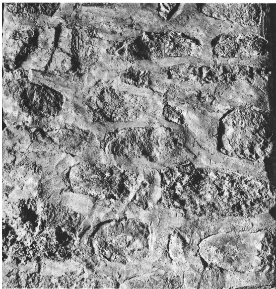
Abb. 10 Ursprünglicher »Fugenputz« an einem Pfeiler im Innern der Kirche. Foto G. Howald. Joint original sur un pilier. Incamicatura originale su un pilastro.
