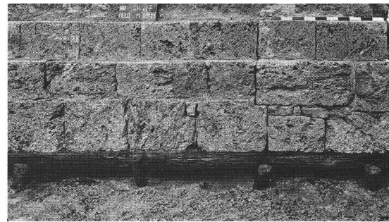
Abb. 7 Blick von Osten auf die romanische westliche Grundmauer des östlichen Kreuzgangflügels. Unten die durch seitliche Pfähle vor dem Abgleiten von den Pfahlköpfen bewahrten Bohlen, oben der Fundamenteinsprung, über dem das vorgesehene Fussbodenniveau eingeritzt war. Fondations du mur ouest de l'aille orientale du cloître roman. Vue prise de l'est. Vista dall'est sul muro di fondazione ovest romano del chiostro.
