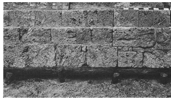
Abb. 7 Blick von Osten auf die romanische westliche Grundmauer des östlichen Kreuzgangflügels. Unten die durch seitliche Pfähle vor dem Abgleiten von den Pfahlköpfen bewahrten Bohlen, oben der Fundamenteinsprung, über dem das vorgesehene Fussbodenniveau eingeritzt war. Fondations du mur ouest de l'aille orientale du cloître roman. Vue prise de l'est. Vista dall'est sul muro di fondazione ovest romanico del chiostro.
