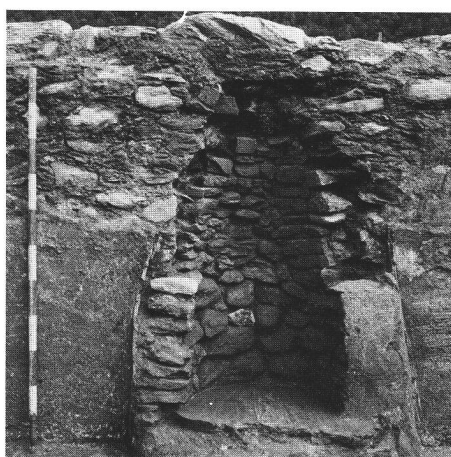
fig. 10b Insula 6, local 42. La cheminée encastree dans un mur, vue du nord-ouest. Insula 6, Raum 42. Blicke auf das Cheminée. Insula 6, locale 42. Vista sul caminetto incastrato nel muro.
