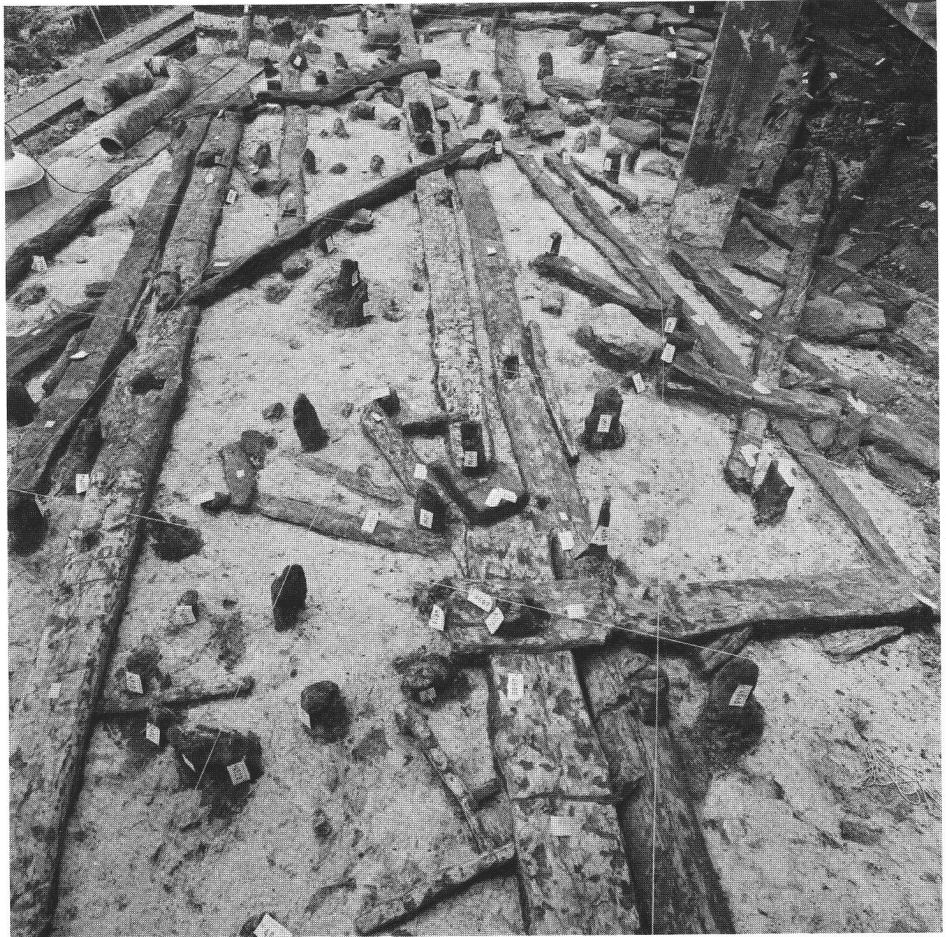
Abb. 6 Schwellholzkonstruktionen. In Bildmitte vierkantig bearbeitete Schwelle mit darauf liegender Quer- verbindung der jüngeren Bauphase. Daneben lie- gende halbrunde Schwelle der älteren Bauphase. Structure de fondations en bois. Au centre poutre et surmontées par des entretoises de la période récen- te. A côté, bois refendus de la période ancienne. Costruzioni di legno di soglia.
