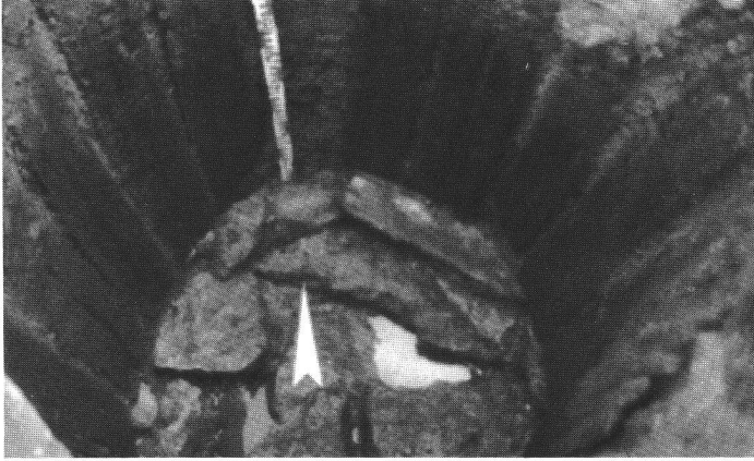
fig. 4 Puits à tonneau. Ein Fass dient als Auskleidung eines Brunnens. Fonte a botte.
