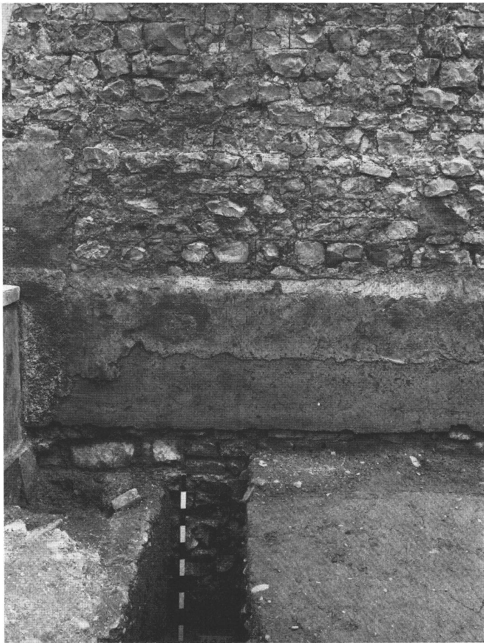
Abb. 14c Die durch mehrere Fasen (geringer Mauereinzug) gegliederte Ostmauer. Detail südlich des Bassins. Le mur méridional présente plusieurs petites retranches. Un détail au Sud du bassin. Il muro est con da varie scalinate. Dettaglio a sud del bacino.
