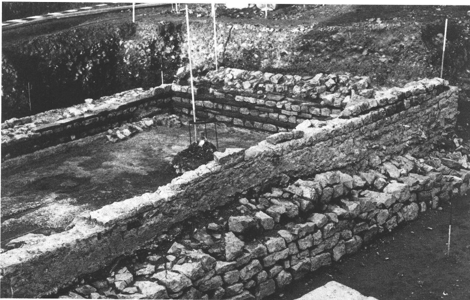
Abb. 10 Grenzach »Steingasse« Bau I mit Kaltwasserbecken (piscina) auf dem Fundament eines älteren Gebäudes. Hydraulischer Estrich, Ausgleichs- schichten aus flachen Ziegelplatten (Leistenziegel).
