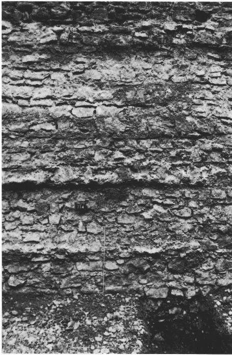
Abb. 8 Leonhardsgraben 43: Rückseite der Innern Stadtmauer. Leonhardsgraben 43: face arrière de l'enceinte interne. Leonhardsgraben 43: il retro del muro della città interno.
