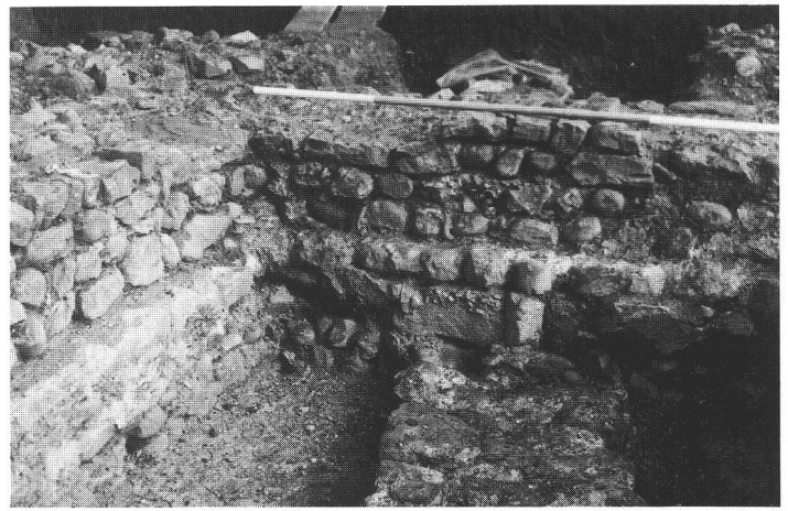
Abb. 6 Handwerkerhaus (Gebäude 4). Südostecke des linken mittleren Raums. Unten Teile der Sickerstückung, darüber zwei Lagen der breiten Grundmauer, darüber drei bis vier Lagen des schmälere, aufgehenden Mauerwerks. Im spitzen Winkel, unter der Grundmauer, die Grundmauer eines älteren Steinhauses.
