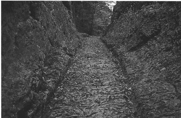
fig. 15 Voie taillée du Haut Hauenstein. Photo F. Mottas. Das Trasse am Oberen Hauenstein mit Abarbeitungen. La via del Hauenstein superiore con tracce di lavorazione.
