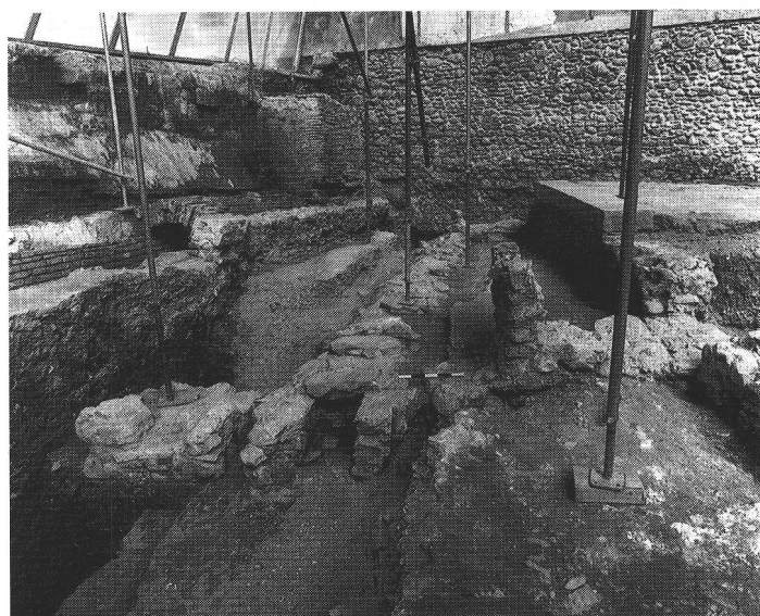
fig. 7 Le pilier axial de la salle centrale; sur sa droite la canalisation avec sa couverture intacte. Photo J.-B. Sevette. Stützpfeiler der zentralen Halle; rechts die Kanalisation mit intakter Abdeckung. Pilastro di sostegno della sala centrale; a destra si vede la canalizzazione con la copertura intatta.
