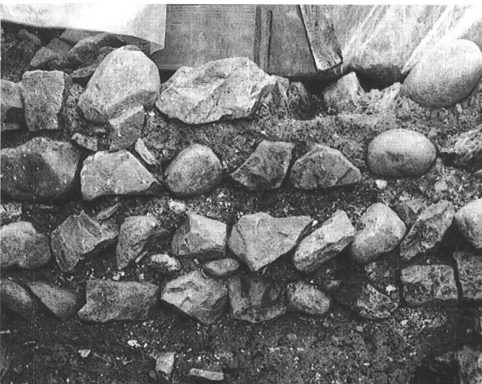
fig. 5 En haut: Les fondations de l'angle sud-est du grand bâtiment construit sur l'emplacement des thermes repose directement sur le terrazzo de la villa. En bas: Les premières assises de ces soubassements sont constituées de pierres mêlées à de la terre. Photos J.-B. Sevette. Oben: Die Fundamente der Südost-Ecke des über den Thermen errichteten Gebäudes ruhen unmittelbar auf dem Terrazzoboden der Villa. Unten: Die unterste Fundamentlage besteht aus einem Stein-Erde-Gemisch. In alto: le fondamenta dell'angolo sud-orientale del grande edificio costruito sul sito delle terme si trovano direttamente al di sopra del pavimento in terrazzo della villa. In basso: la base delle fondamenta è costituita da una miscela di pietre e terra.
