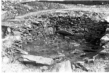
fig. 3 Bâtiment semi-enterré en pierre sèche d'époque gallo-romaine (fin 1er/début 2ème siècle ap. J.-C.). Photo B. de Peyer. Eingetieftes Gebäude aus Trockenmauern der römischen Zeit (Ende 1./Anfang 2. Jahrhundert n.Chr.). Edificio semi-interrato a secco dell'epoca gallo-romana (fine del I/inizio del II sec. d.C.).
