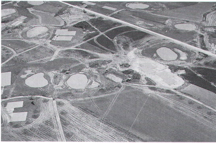
Abb. 2 Blick auf die »Patchwork-Landschaft« der Baustelle. Für die Anlage der Spielbahnen (»Green«) des Golfparks sind grossflächige Terrainveränderungen notwendig. Foto KA ZH, P. Nagy.
