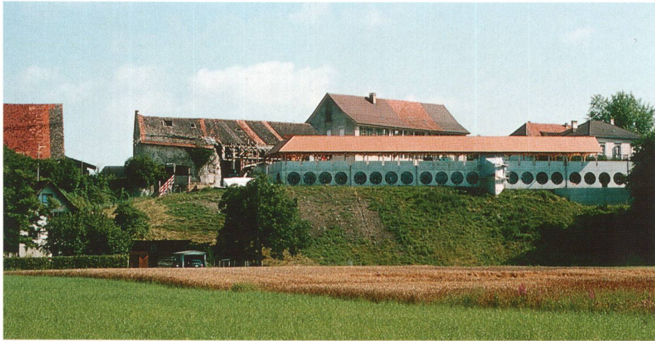
Abb. 1 Pfyn, Städtli. Trotte, Schloss/ Schulhaus und Neubau von Süden. Foto Amt für Denkmal- pflege Thurgau. Pfyn, Städtli. Bâtiment du pressoir (Trotte), château/école et nouveau bâtiment, vue du sud. Pfyn, Städtli. Cantina vinicola, castello/scuola e costruzione recente visti da sud.
