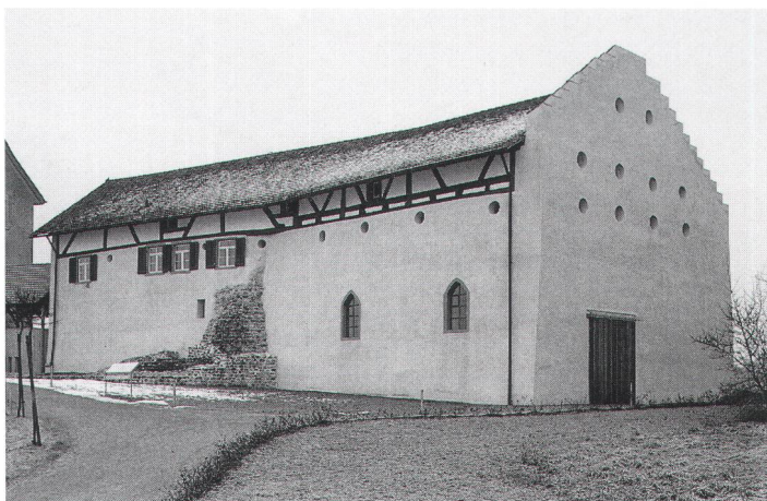
Abb. 4 Pfyn, Städtli. Trotte, Nordwestfassade mit Eckturm des Kastells von NW. Foto Amt für Denkmalpflege des Kt. Thurgau. Pfyn, Städtli. Bâtiment du pressoir (Trotte), facade nord- ouest avec tour d'angle du castrum, vue du nord-ouest. Pfyn, Städtli. Cantina vinicola, facciata nord-occidentale con torre d'angolo del castello. Vista da nord-ovest.
