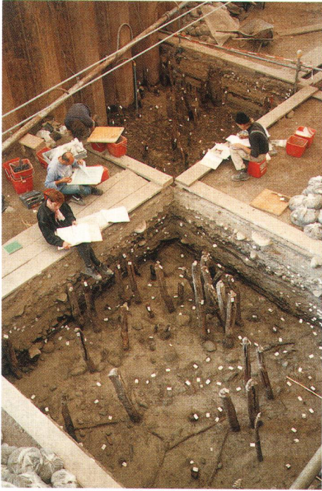
fig. 8 Les grandes interventions de sauvetages programmées ne concernent pas que les autoroutes: la construction de la nouvelle voie ferrée Rail 2000 à Concise (VD) nécessite la fouille d'une grande partie d'un site littoral Néolithique-Bronze ancien. Photo MHAVD.
