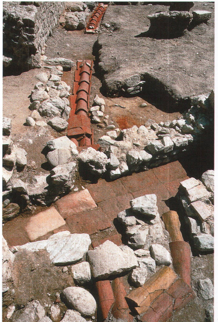
fig. 12 → Drain en tuiles se déversant dans l'égout secondaire. Photo Archeodunum S.A. Entwässerungsgraben mit Abfluss in eine Nebenkanalisation. Tubo di drenaggio in tegole riversante nel canale secondario.
