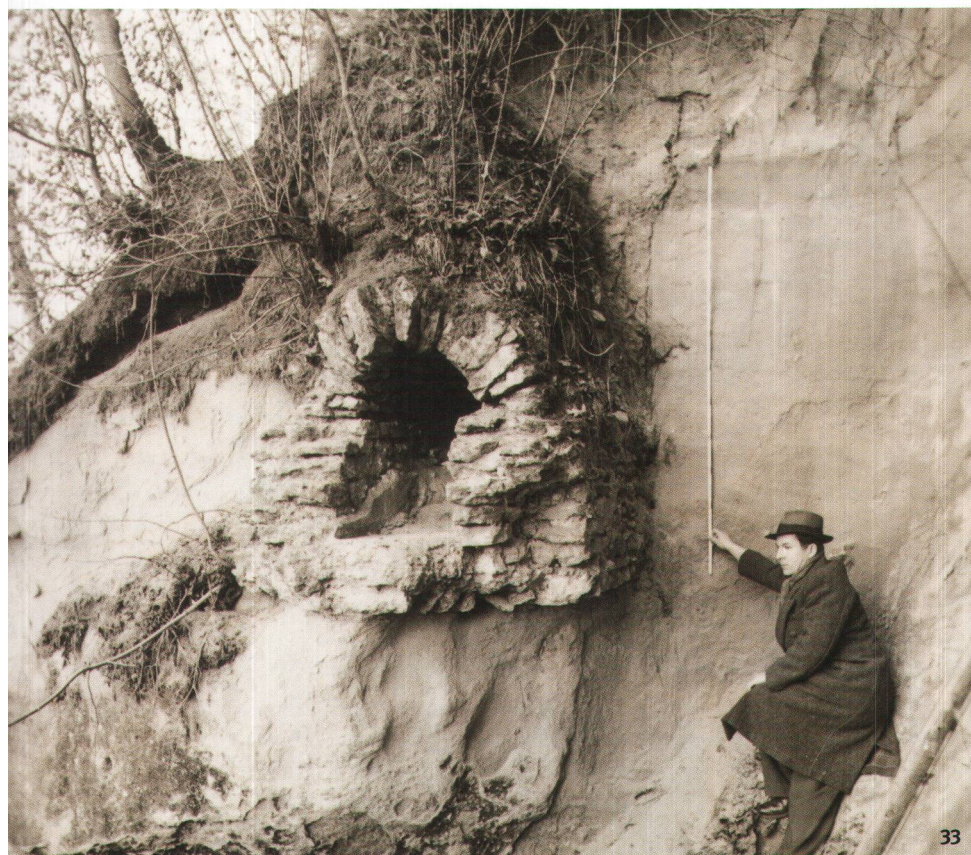
Abb. 33 Einer der Aquädukte von Aventicum in der Nähe des Weilers Coppet im Südwesten der Stadt.
