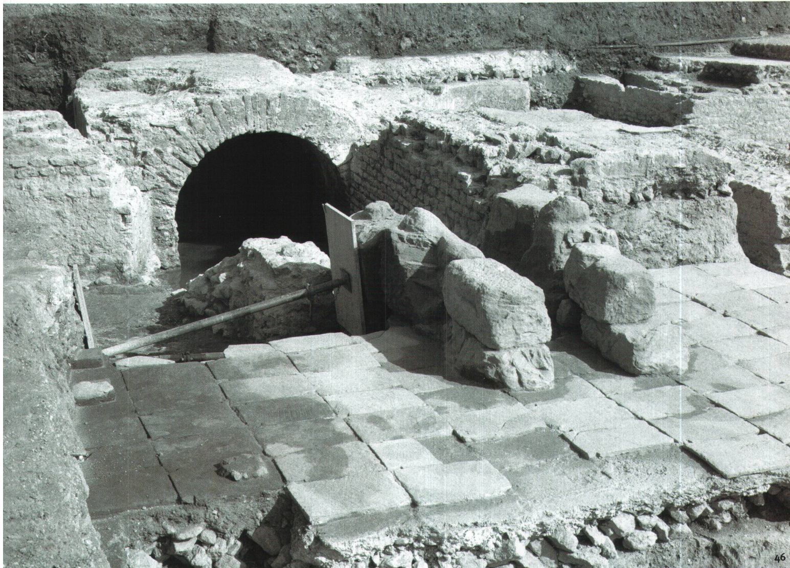
Abb. 46 Die Thermen in der insula 19, Anfang 2. Jh. Gut erhaltener unterirdisch angelegter Service- Gang, von dem aus mehrere Heizanlagen ( praefurnia ) bedient wurden.
