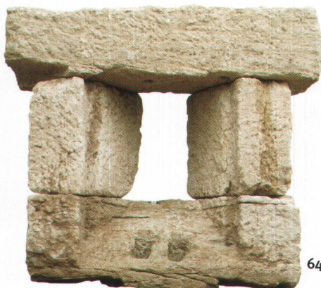
Abb. 64 Wieder aufgebautes, hoch gelegenes Fenster des Tresorgebäudes in der insula 7 . Die enge Öffnung besass als zusätzliche Sicherung eine doppelte Reihe von Eisenstäben und einen Fensterladen mit Riegel. Sandstein, Öffnung: 53 x 21 cm.
