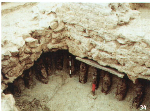
Fig. 34 Pieux en chêne datés par la dendrochronologie de 29 apr. J.-C. soutenant les fondations des thermes de l'insula 19.
