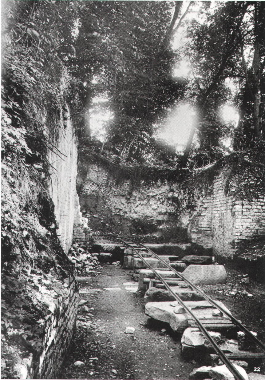
Abb. 22 Karl Stehlin und Theophil Burckhardt-Biedermann begannen mit systematischen Ausgrabungen im Theater. Tonnen von Erdreich liessen sie über Wagen auf Schienen abtransportieren.
